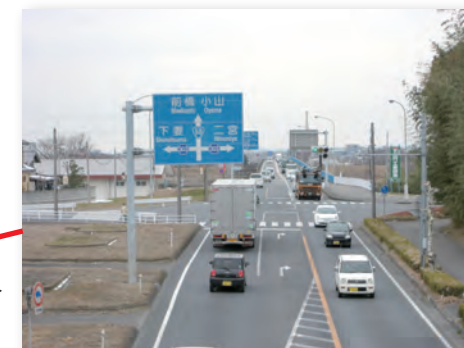
国道50号結城バイパス 鬼怒川大橋直進
